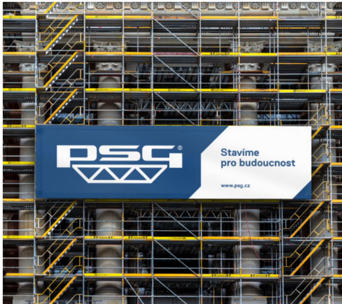
Ukázka umístění plachty na stavbu.
