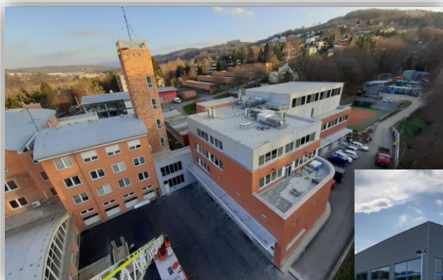
CPS Zlín – dostavba a rekonstrukce stanice
