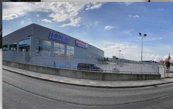
Retail Park Severka – výstavba autobazaru
